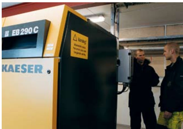
Regular los soplantes con variadores de velocidad Emotron ha educado el consumo de energía y el desgaste de los equipos. Johan Arvidsson (derecha) con el comercial de Emotron Peder Wale (izquierda).
