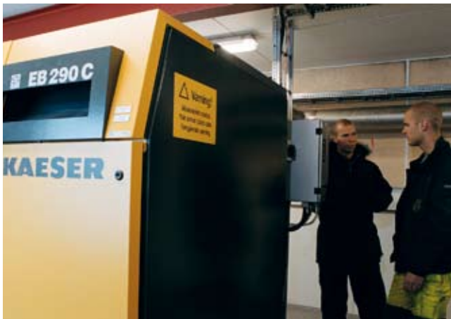
使用Emotron变频调速器调节鼓风机,降低了能量消耗和设备磨损。右侧是Johan Arvidsson,左侧是Peder Wale,Emotron的销售代表。
