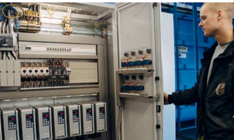
淤泥在离心机脱水,离心机的螺旋输送机受7台Emotron MSF软起动器控制。淤泥则用做肥料,或送去做最终处理。
