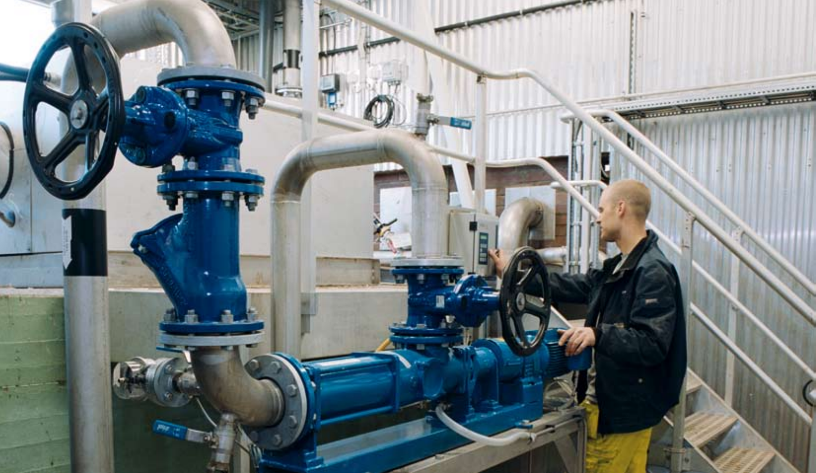
Johan Arvidsson, Svenljunga污水处理厂的电工, 监控离心泵, 这台泵是将淤泥抽到脱水机。这台泵由Emotron FDU变频调速器控制。Emotron M20轴功率监视保护器确保不会有东西堵在螺旋输送机内。“Emotron产品的一个优点是抗恶劣环境, 因此能安装在工厂内, 无须昂贵的电缆或机柜。”
