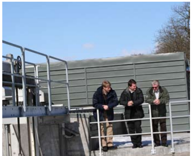
En Södra Dämmet, el agua del sistema de canales se bombea al río Helge cuando el nivel sube demasiado. De izquierda a derecha: Calle Croona (agente comercial de Emotron), Patrik Almlöf (jefe de proyecto de Malmberg Water) y Lennart Hermansen (director de obras de C4 Teknik).
